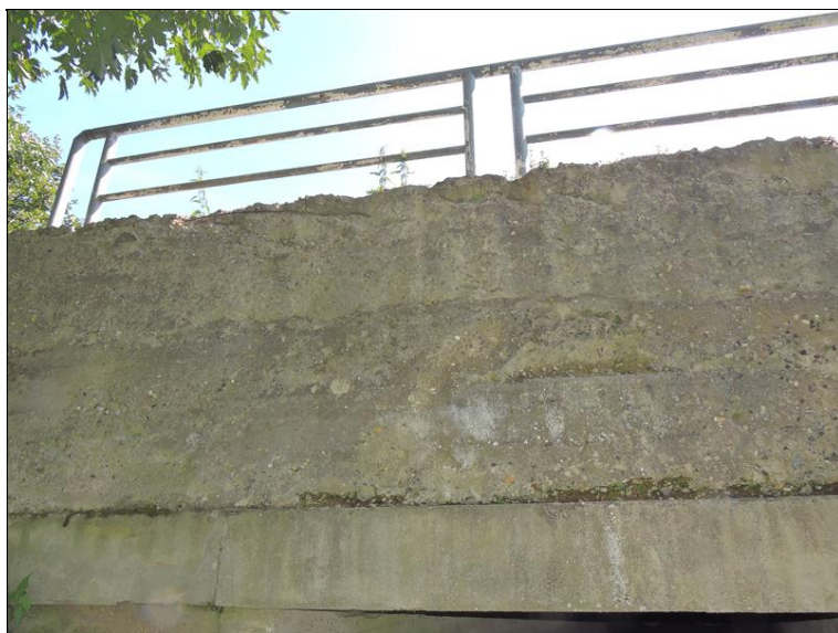
Levá strana - degradace betonu čela, viditelná zkorodovaná výztuž
